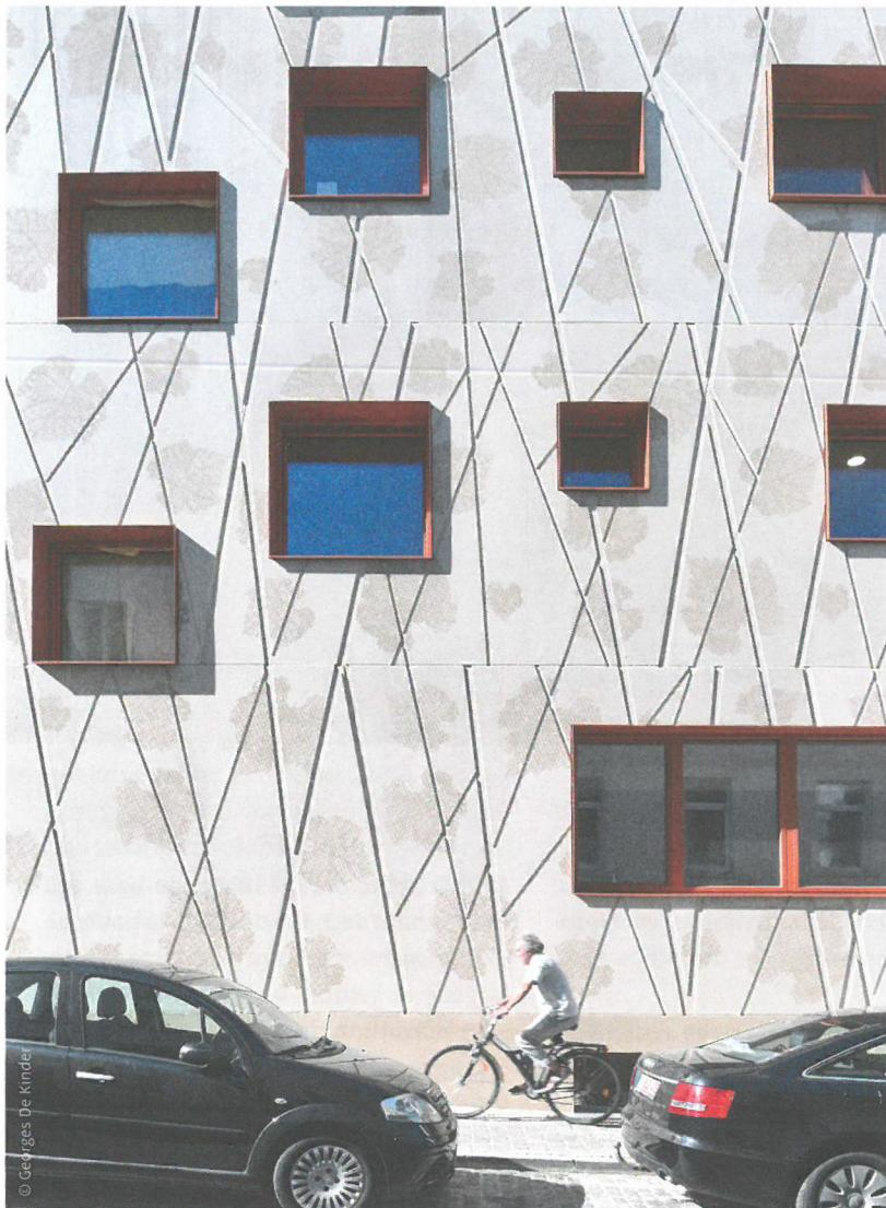
*Het basisbeeld van het groen is 3,5 m hoog – de hoogte van een verdieping – en 3,2 m breed – het maximale drukformaat van Graphic Concrete.*
